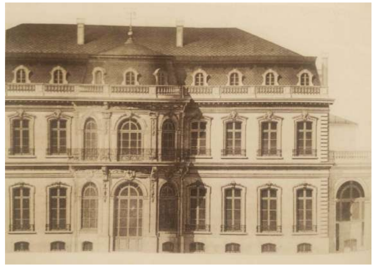
FACHADA DE HÔTEL PRIVÉ DE PRIMEIRA CLASSE, CONFORME PROJETO DOS ARQUITETOS NOLAU E CONVENTS, APRESENTADO POR CÉSAR DALY, EM 1867. (FONTE: HOMEM,1996,P.24)
