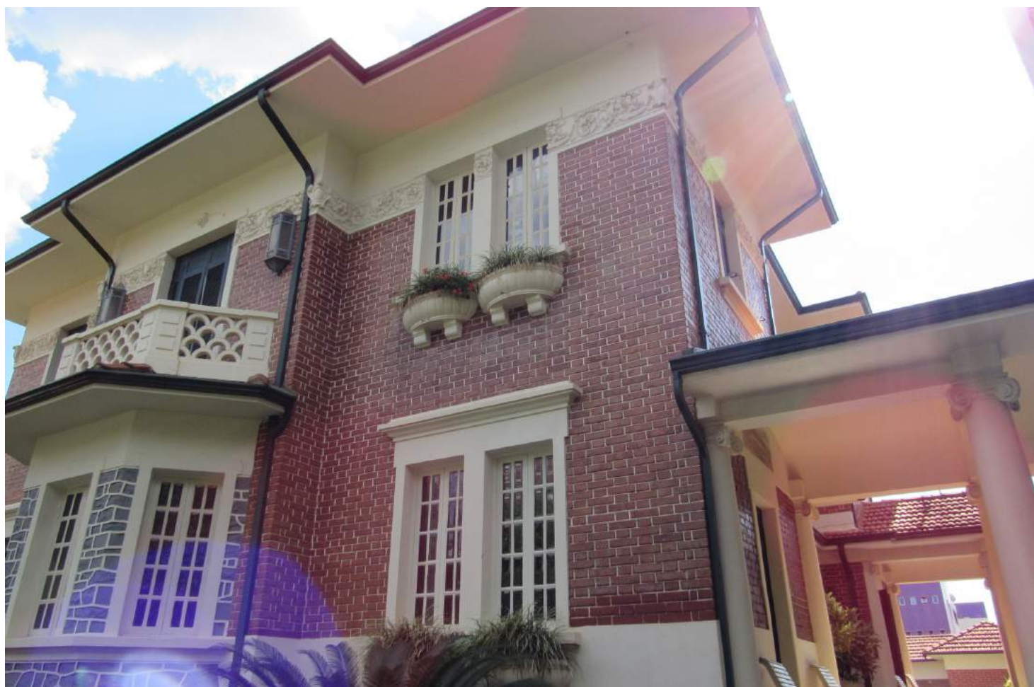
Casa da Memória Italiana (fachada principal com suas numerosas aberturas) - Foto por: Luís R. Pascual Neto
