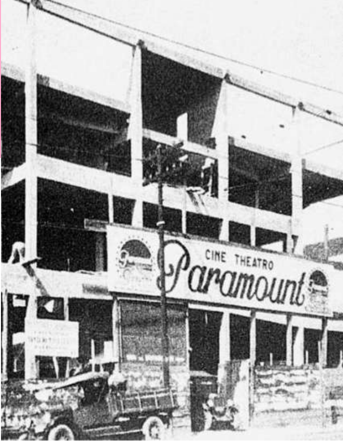
O CINEMA EM CONSTRUÇÃO - 06/1928
