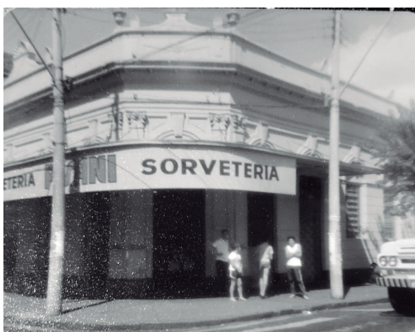
Fachada da Sorveteria Pisani, localizada na esquina da rua Visconde de Inhaúma com a Florêncio de Abreu, Centro de Ribeirão Preto
