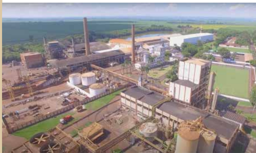
Usina Santo Antônio.
