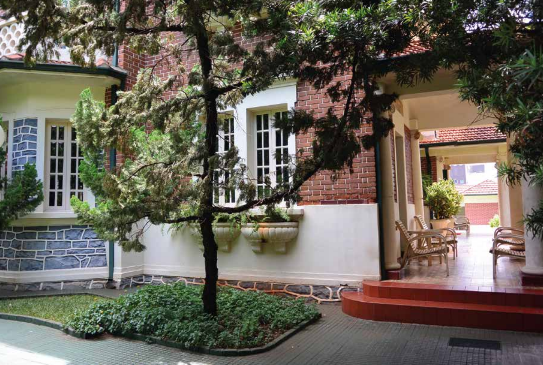
Detalhe da fachada principal da residência da rua Tibiriçá, 776. Foto: Nilton Campos e Rosa Esteves, novembro de 2013.
